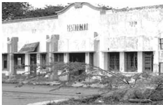
Fachada actual del inmueble donde funcionó el restaurante El Mesol, el comisariato y finalmente El Flamboyán, de Punta Cardón
