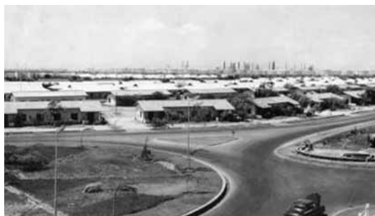
Parte de Campo Shell, vista desde el hospital Cardón
