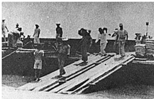
Descarga de materiales de la primera gabarra que arribó en La Botija
