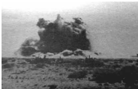
Parte dinamitada para la instalación de la refinería en La Botija.
