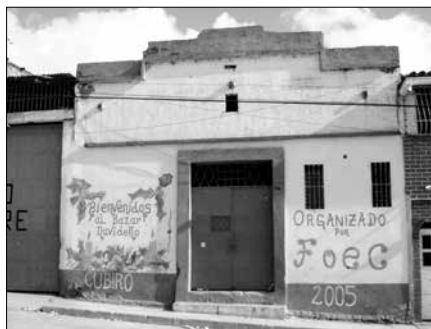
Fachada de lo que fue el cine Principal, en Cubiro.
