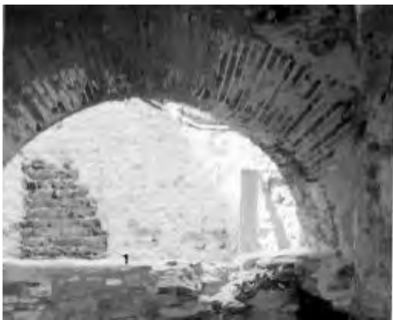
Figura 27: Excavación de la Escuela José Ángel Lamas, recinto 3 .
