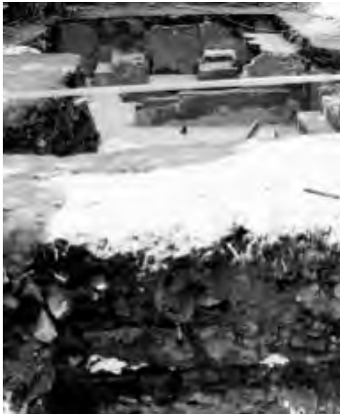
Figura 37: Casa Mendoza: excavación para construir un tanque de agua. Pared sur Ángulo suroeste, pared oeste, vista este.
